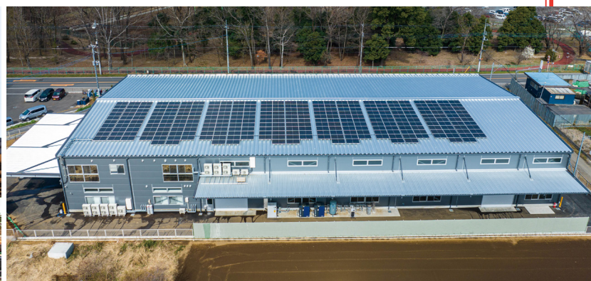
新工場の屋根には50kWの自家消費型の太陽光発電システムが設置されている
